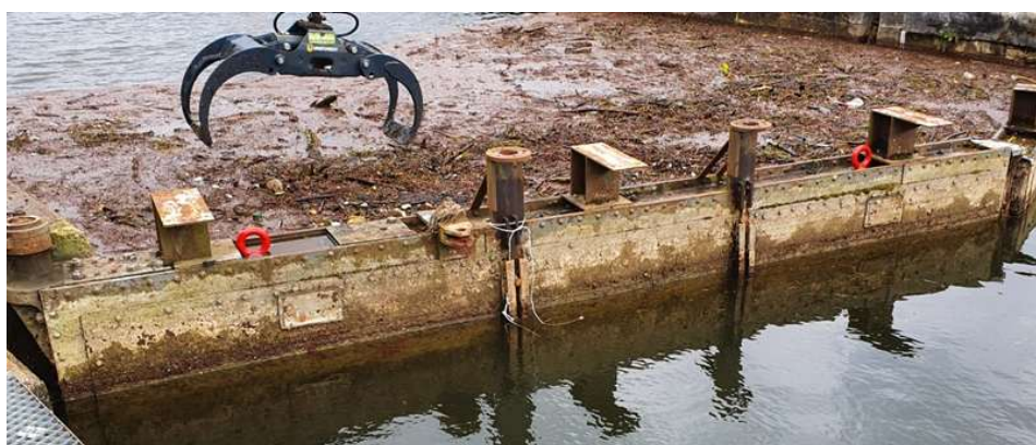
Photo 61 : Anneaux de levage sur vantail – écluse des Boisseaux (Source - LM INGENIERIE)
