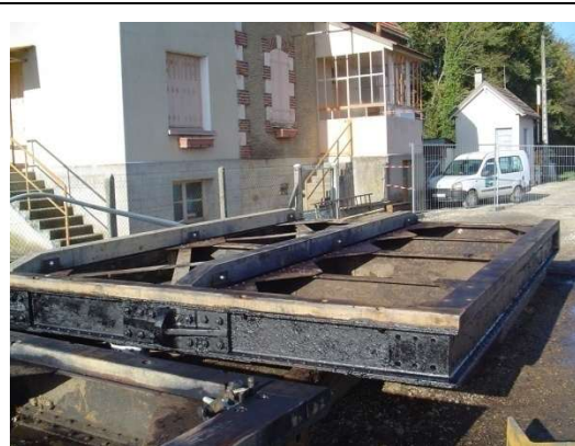
Photo 63 et Photo 64 : Exemple d'étanchéité bois (autre écluse)
