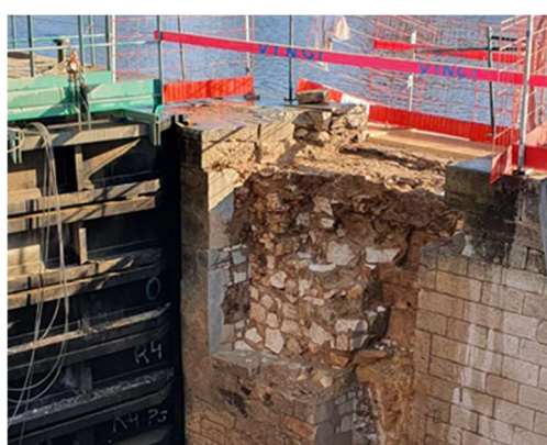
Photo 69 : Démolition des maçonneries – écluse des Boisseaux (Source - LM INGENIERIE)
