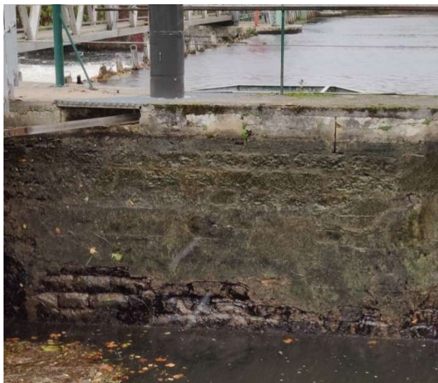
Photo 34 : maçonnerie de la chambre de porte RD – tête aval (VNF - 20/10/2022)
