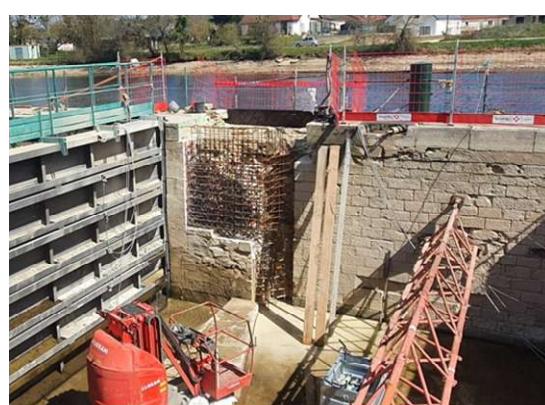
Photo 70 : Ferrailage du bajoyer – écluse des Boisseaux (Source - LM INGENIERIE)
