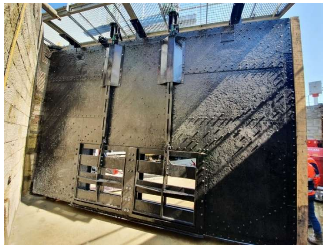
Photo 62 : Protection de brimbale – écluse des Boisseaux (Source - LM INGENIERIE)
