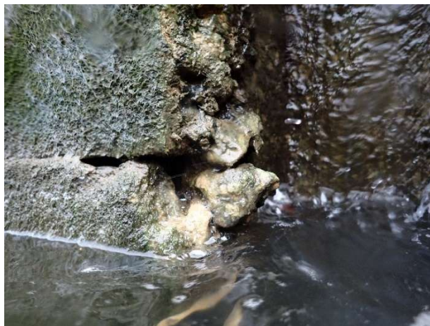
Photo 11 : Rainure aval rive droite – tête amont (Inspection par plongeurs)
