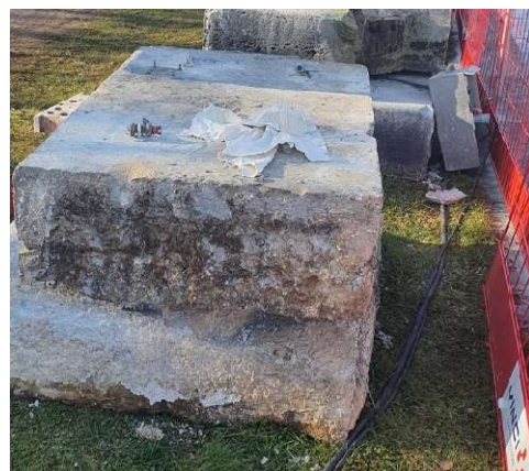
Photo 67 : Anneaux de levage sur pierre de couronnement – écluse des Boisseaux (Source - LM INGENIERIE)
