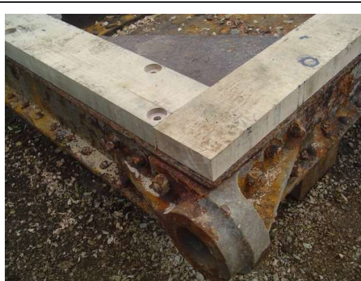
Photo 63 et Photo 64 : Exemple d'étanchéité bois (autre écluse)
