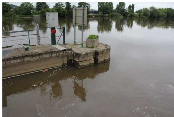
Photo 4 : Coffret de proximité et sonde de niveau RD – tête amont (LM INGENIERIE - 02/07/2024)
