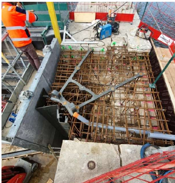
Photo 71 : Araignée – écluse des Boisseaux (Source - LM INGENIERIE)
